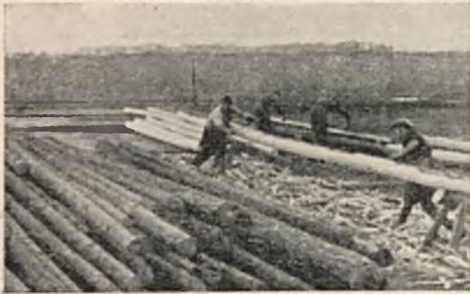
RYS. 1. PRZYGOTOWANIE SŁUPÓW DO IMPREGNACJI.
