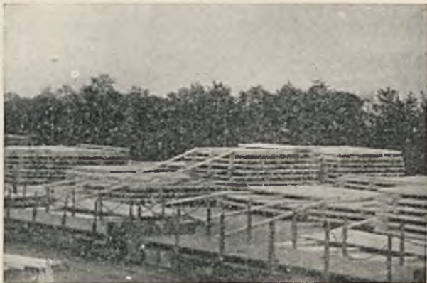
RYC. 29. ODBIÓR SŁUPÓW NA STACJI ZAŁADOWCZEJ.
