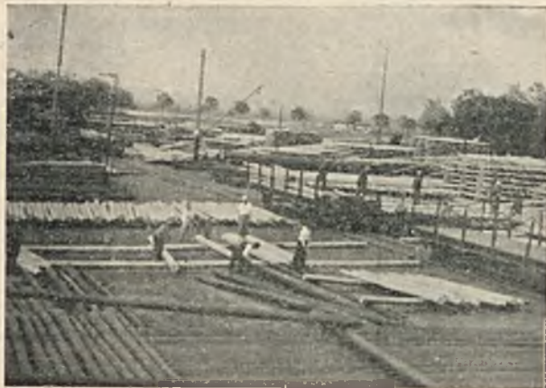
RYS. 30. ODBIÓR NA PLACU NASYCALNI.
