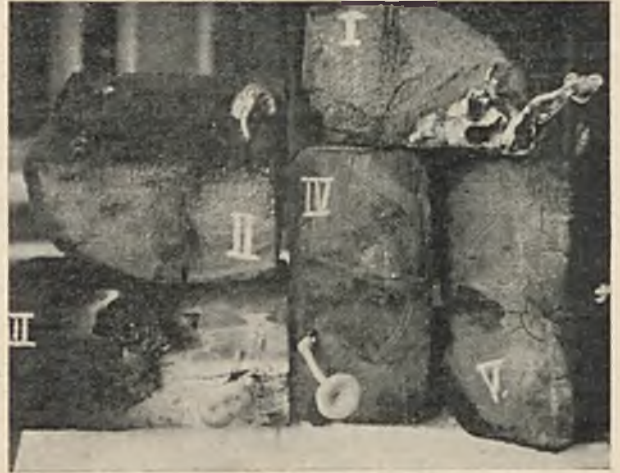
RYS. 21. TWARDZIAK NA PODKLADACH KOLEJOWYCH
