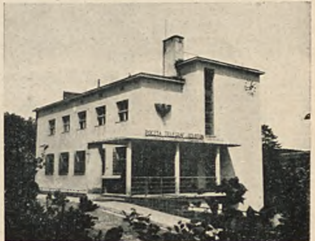
RYS. 6. URZĄD POCZT.-TELEKOM. W IWONICZU.
