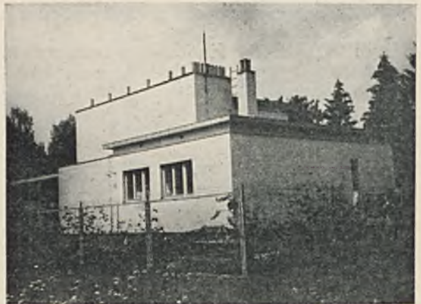
RYS. 2. CENTRALA AUTOMATYCZNA W MILANÓWKU.
