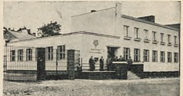
RYS. 5. URZĄD POCZT.-TELEKOM. W SOKÓLCE.
