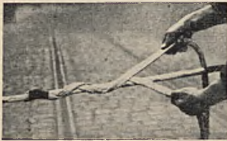
RYC. 8. SPOSÓB NAKŁADANIA BANDAŻA NA KABEL.
