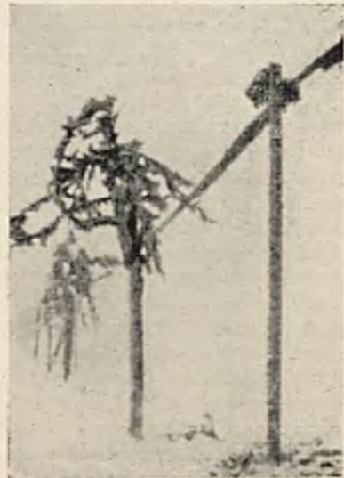
RYC. 15. WARUNKI PRACY KABLA SAMOWISZĄCEGO NA ODCINKU PRÓBNYM.
