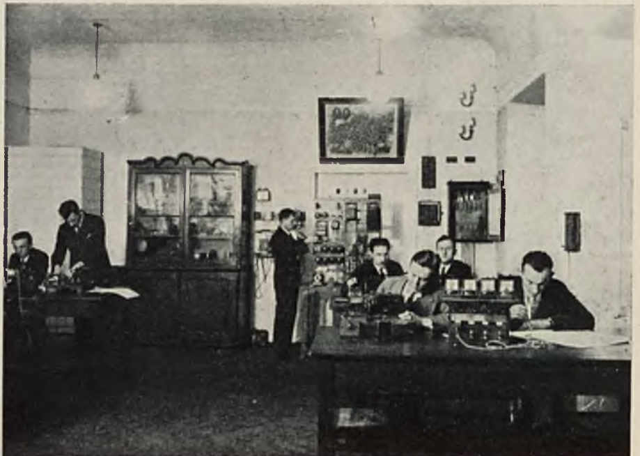
RYŚ. 2. DAWNA PRACOWNIA TELETECHNICZNA W GMACHU PRZY PLACU NAPOLEONA.
