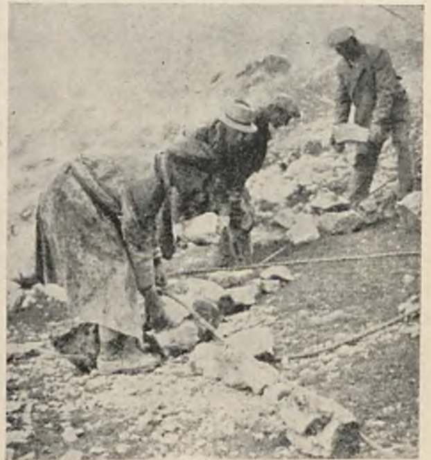
RYC. 7. UKŁADANIE PIĘTEL NA TRASIE KABLA W G. PARTENKIRCHEN.
