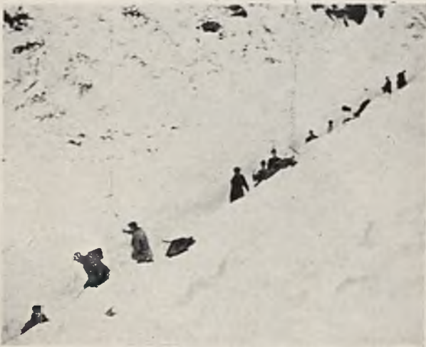
RYC. 2. WYKOP W ŚNIEGU (2½ M) ZIEMI PRZED UŁOŻENIEM KABLA.
