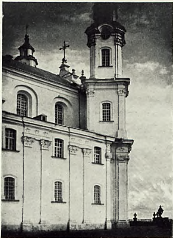
9. Poczajów, Cerkiew Wniebowzięcia N. P. M. Fragment fasady bocznej Fot. H. Hermanowicza (Pracownia fot. Liceum Krzemienieckiego)
