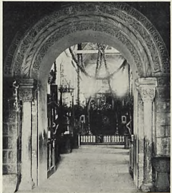
Czerwińsk, portal romański w obecnym stanie
