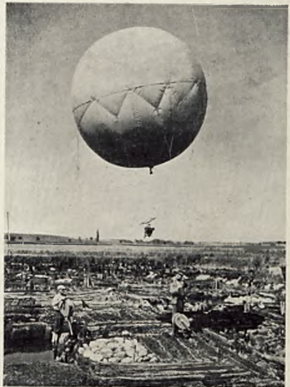
1. Balon o średnicy 5,5 m do zdjęć pionowych (zdjęcia z wysokości 200—1000 m robione z balonu obserwacyjnego)
