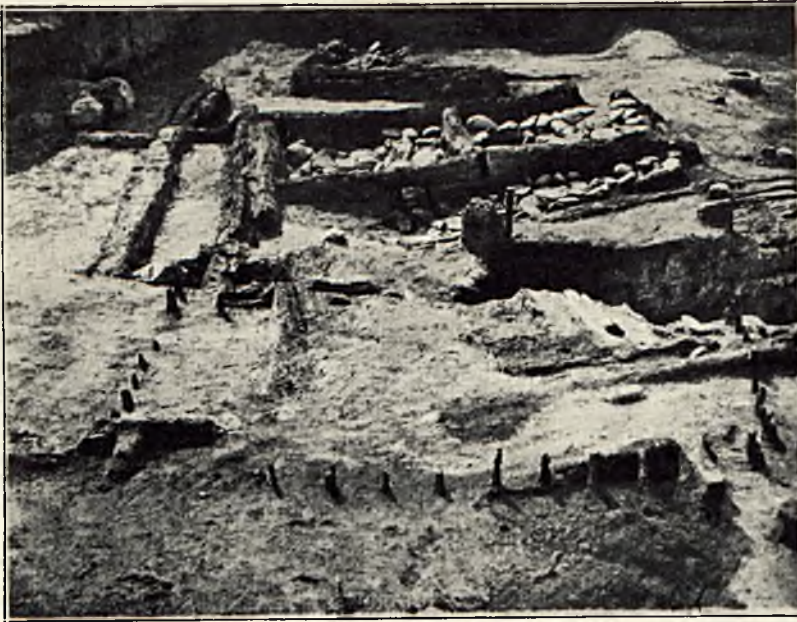
5. Gniezno. Budynek gospodarczy o konstrukcji słupowej z ścianami plecionymi z warstwy V
