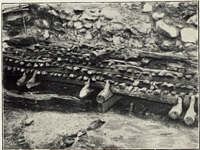
14. Gniezno. Widok wału od strony wewnętrznej. Z tyłu widoczny fundament muru z XIV w.
