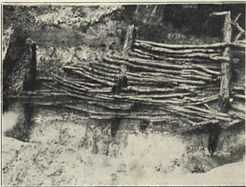
12. Gniezno. Część plecionki wzmacniającej zbocza fosy
