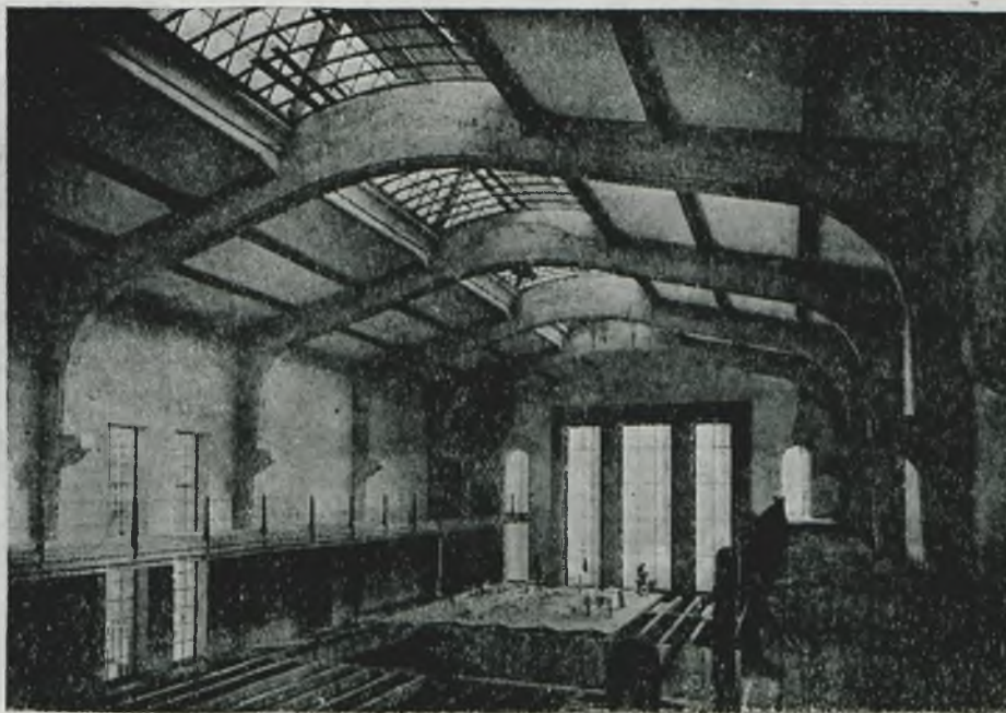
Rys. 8. Wnętrze hali przed wykończeniem.
