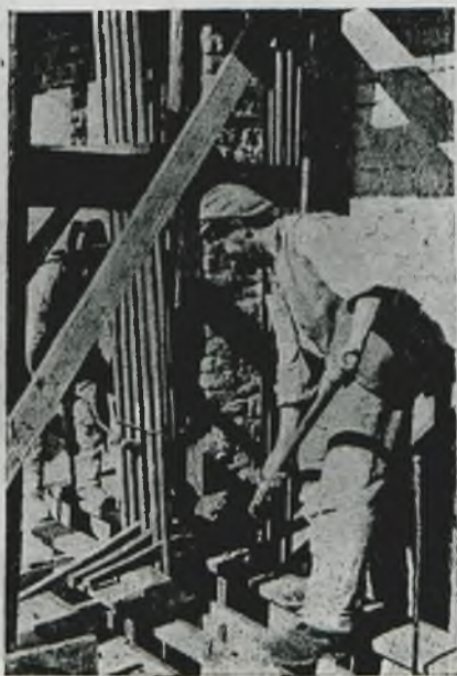
Rys. 5. Betonowanie słupa wieżara ramowego.
