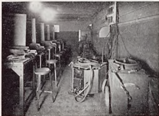
Rys. 9. Spawalnia łukowa Łódzkiego Tow. Kursów Technicznych.
