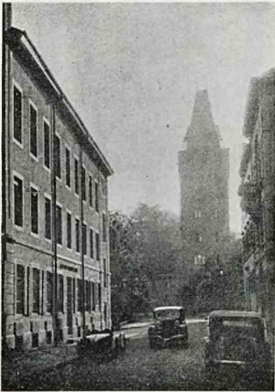
Rys. 1. Widok nowego Domu Spawania w Bazylei.
