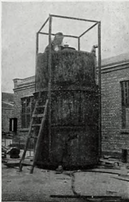
Rys. 11. Zestawiony zbiornik dolny i dzwon, na którym spawacz łukowy umocowuje krążek prowadzący.
