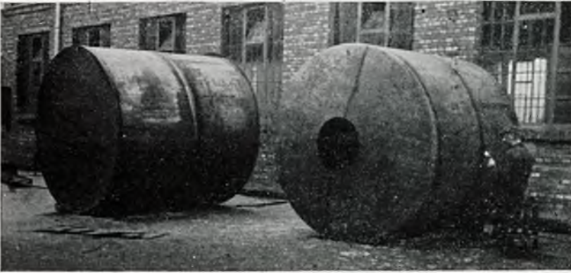
Rys. 12. Spawanie wieńca dzwonu. Na dalszym planie zbiornik dolny po ukończeniu spawania.
