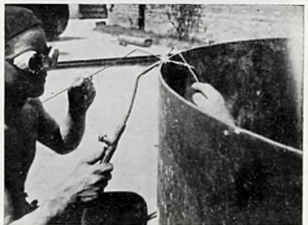
Rys. 3. Spawanie ścian zbiornika metodą dwustronnego spawania „w górę”.
