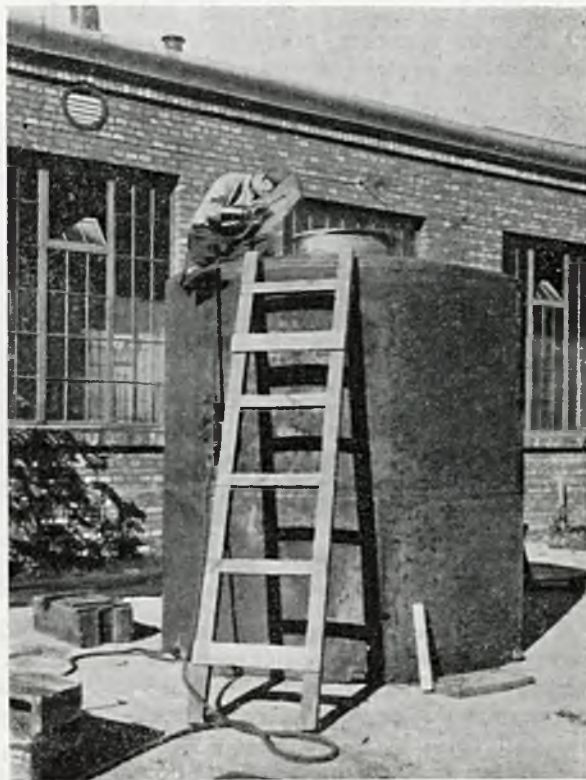
Rys. 10. Przypawanie włazu.
