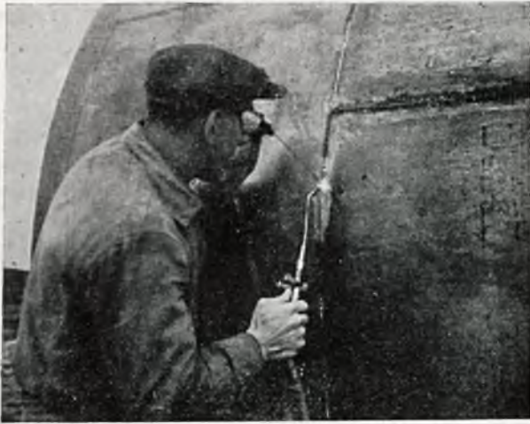
Rys. 4. Wykonywanie podłużnych spoin zbiornika.
