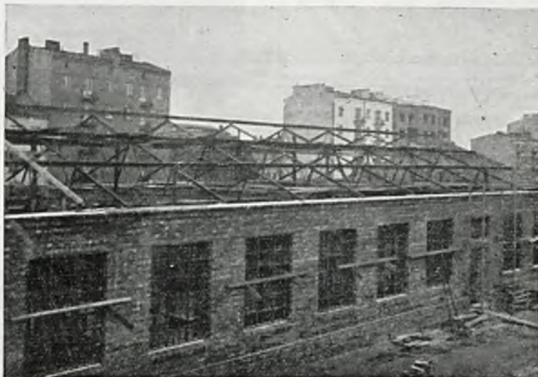
Rys. 1. Widok dachu podczas budowy.
