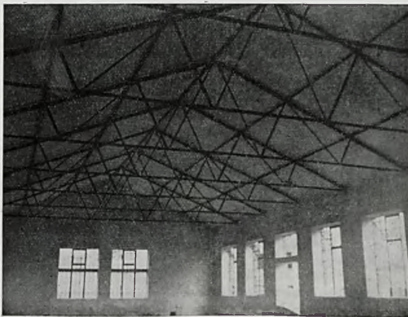
Rys. 2. Widok na całość konstrukcji dachowej po wykonaniu.
