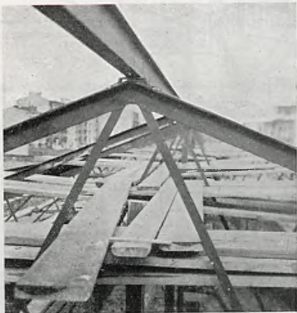
Rys. 11. Umocowanie płatwi szczytowej.
