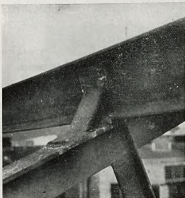
Rys. 10. Umocowanie płatwi na wiażarach.
