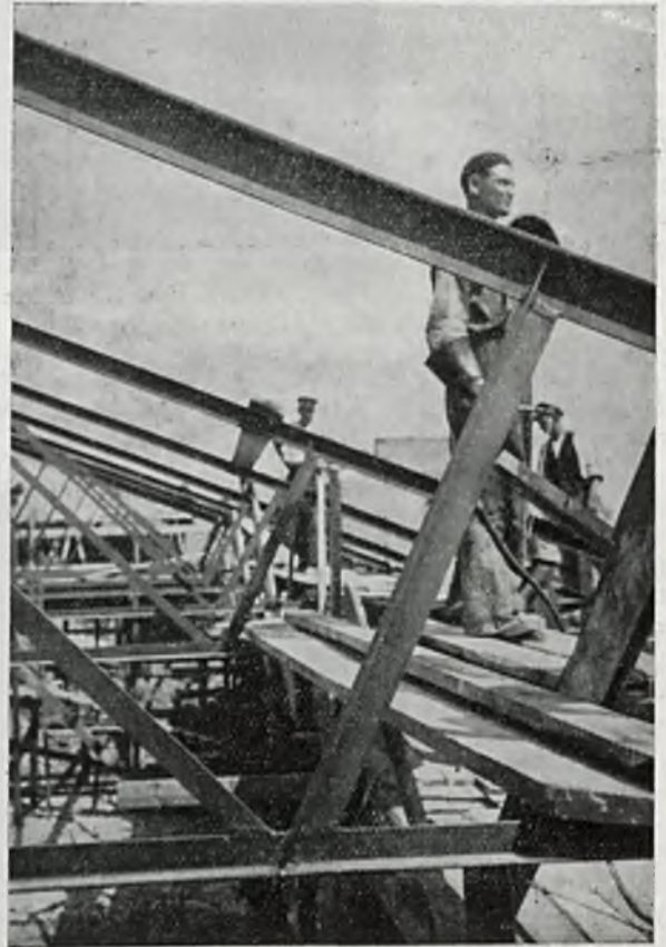
Rys. 5. Połączenie wpustowe pomiędzy słupkami i pasami.
