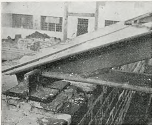
Rys. 7. Węzeł podporowy wiażara.
