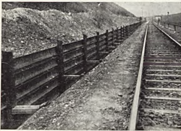
Rys. 8. Ściana oporowa wykonana ze starych podkładów żelaznych.
