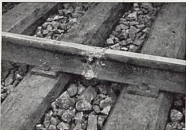
Rys. 4. Styk termitowy naprawiony za pomocą palnika acetylenowego.
