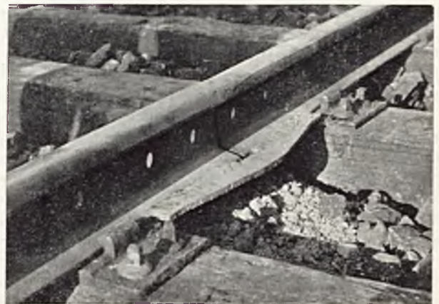
Rys. 6. Styk syst. A. L. f. „Perun”.
