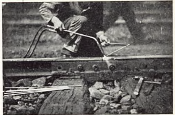
Rys. 2. Napawanie końców szyn palnikiem acetylenowym.
