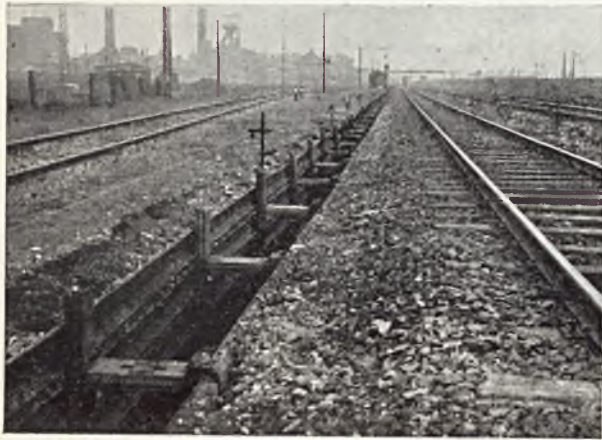
Rys. 7. Ściany rowu ze spawanych starych podkładów żelaznych.
