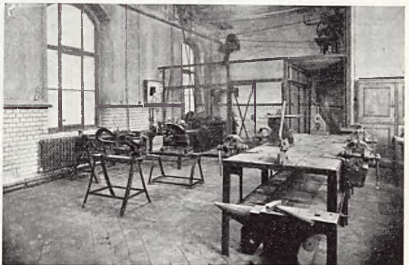
[Rys. 8. Warsztat mechaniczny w Szkole Katowickiej.
