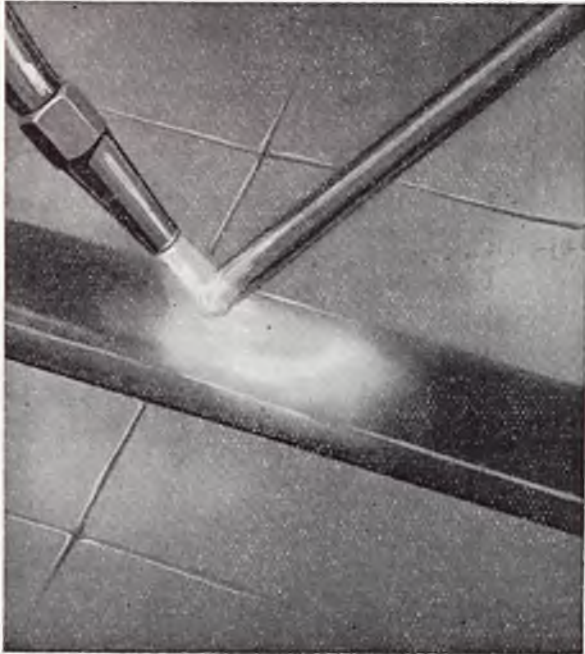
Rys. 16. Nakładanie warstwy Stellite (czynność 6).
