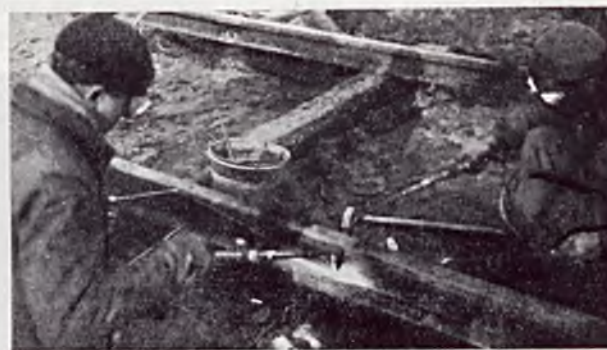
Rys. 11. Spawanie podkładki.
