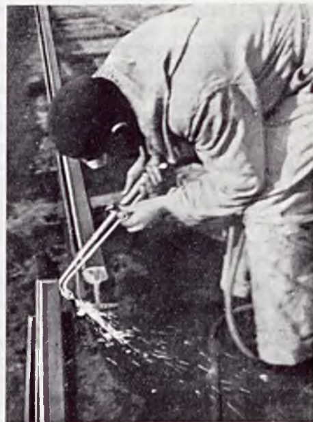
Rys. 2. Ukośnienie końców szyn za pomocą palnika acetylenowego do cięcia tlenu.
