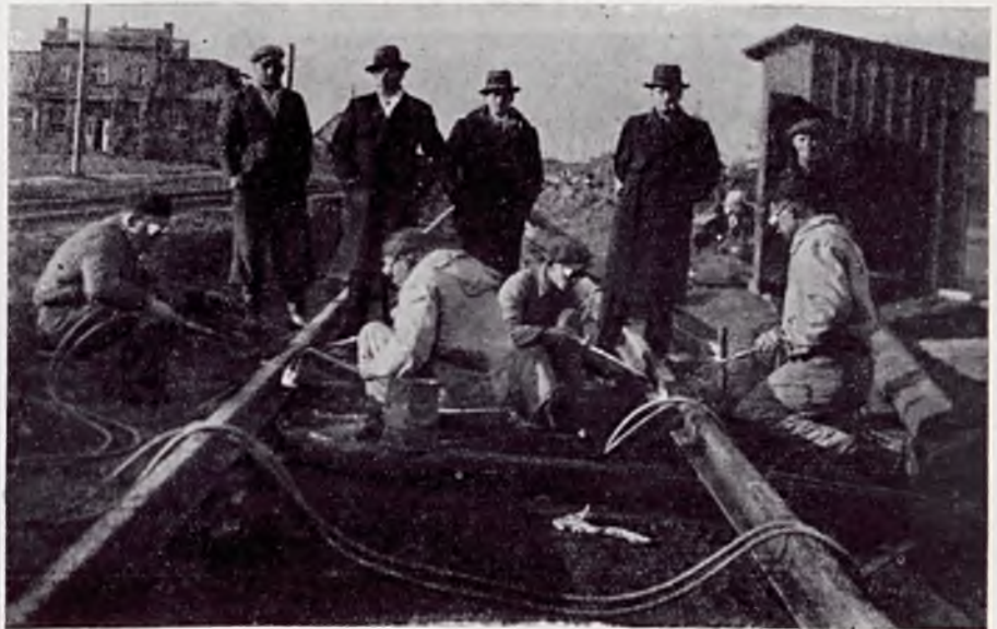
Rys. 6. Widok drużyn spawalniczych przy pracy na linii Czerniaków—Wilanów.
