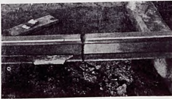
Rys. 4. Złącze przygotowane do spawania.
