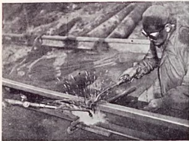
Rys. 7. Spawanie stopki.
