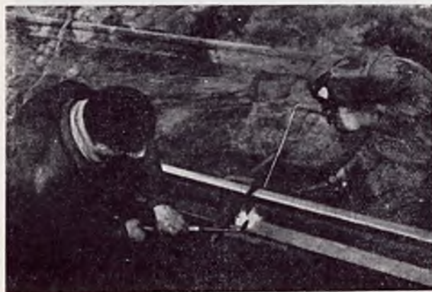
Rys. 8. Spawanie szyjki.
