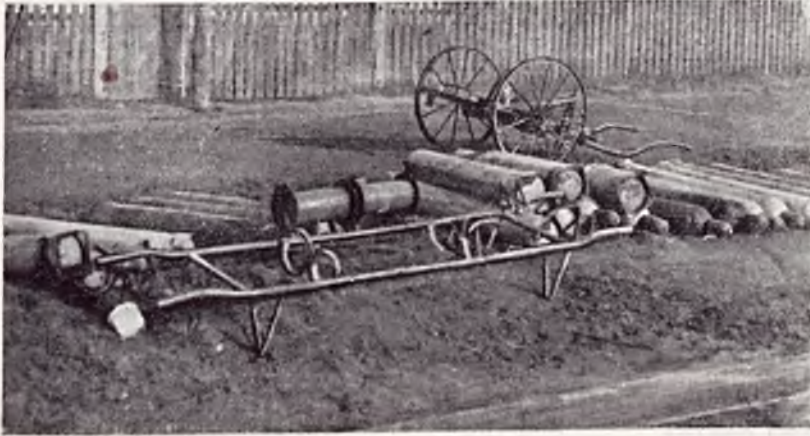
Rys. 13. Nosze i wózek używane do transportu butli wzdłuż toru.
