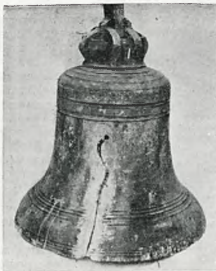
Rys. 9. Dzwon wagi 95 kg., naprawiony za pomocą lutowania w ciągu 7,5 godz.
