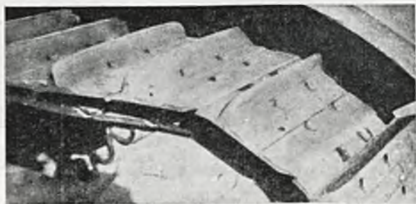
Rys. 6. Szczepki gąsienicowe.
