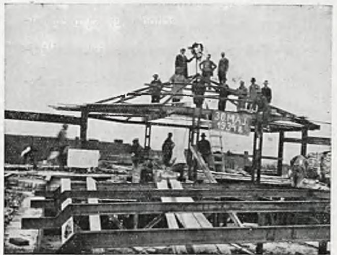
Rys. 12. Krokwie dachowe i świetlik.
