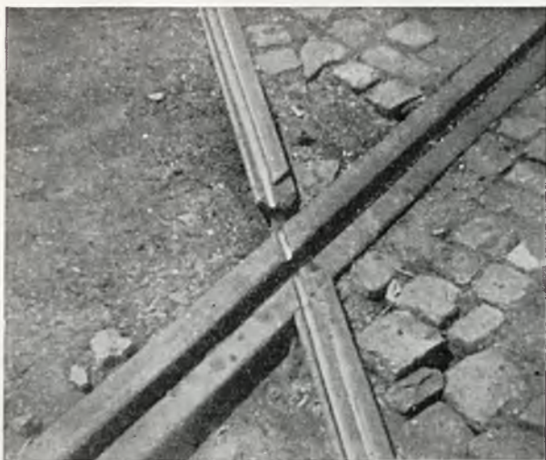
Fig. 5. Uszkodzone krzyżowanie toru tramwajowego.
