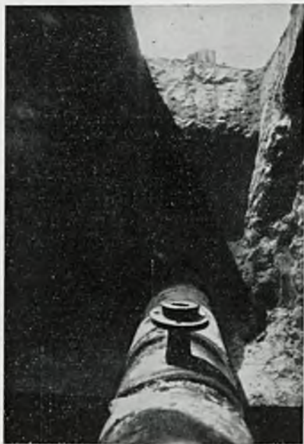
Rys. 9. Króćciec \varnothing 50 mm przypawany do rurociągu Piaśniki — Makoszowy bezpośrednio w wykopie.
