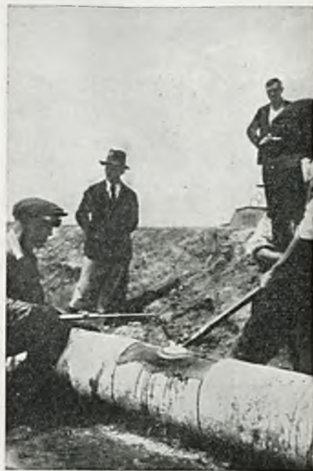
Rys. 6. Wywijanie otworu w rurze dla przypawania króćca \varnothing 50 mm.
