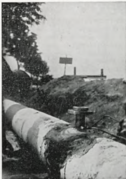
Rys. 8. Przypawanie króćca \varnothing 50 mm przy budowie rurociągu Piaśniki — Makoszowy.
