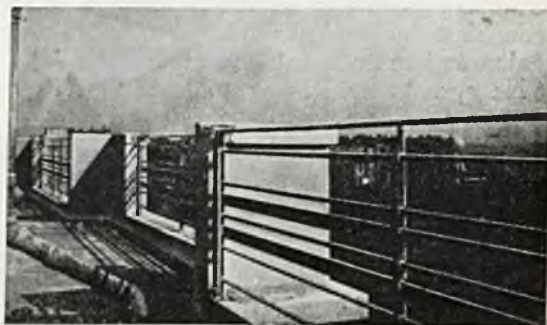
Rys. 18. Balustrada z płaskowników i kratówki, wykonana zapomocą lutowania.
