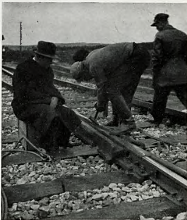
Rys. 2. Obcinanie nadlewków przed ostatecznym wyrównaniem profilu główki zapomocą młotka. Z lewej strony autor artykułu, z prawej spawacz Sztobryn z pomocnikiem.
