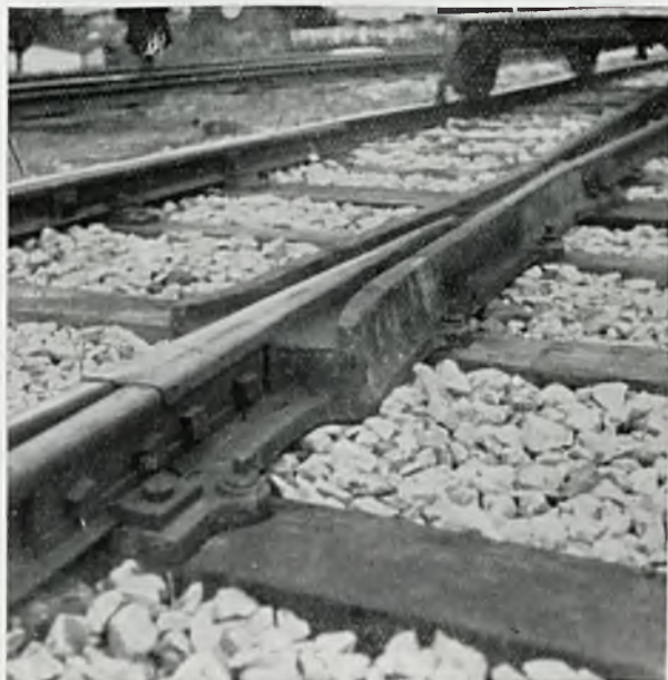
Rys. 4. Naprawiona przez napawanie w torze krzyżownica typu CIV.
