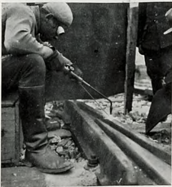
Rys. 1. Napawanie w torze krzyżownicy ze stali lanej. Niezbędna jest zastona od wiatru w celu ochrony przed zbyt szybkim stygnięciem odlewem po napawaniu.
