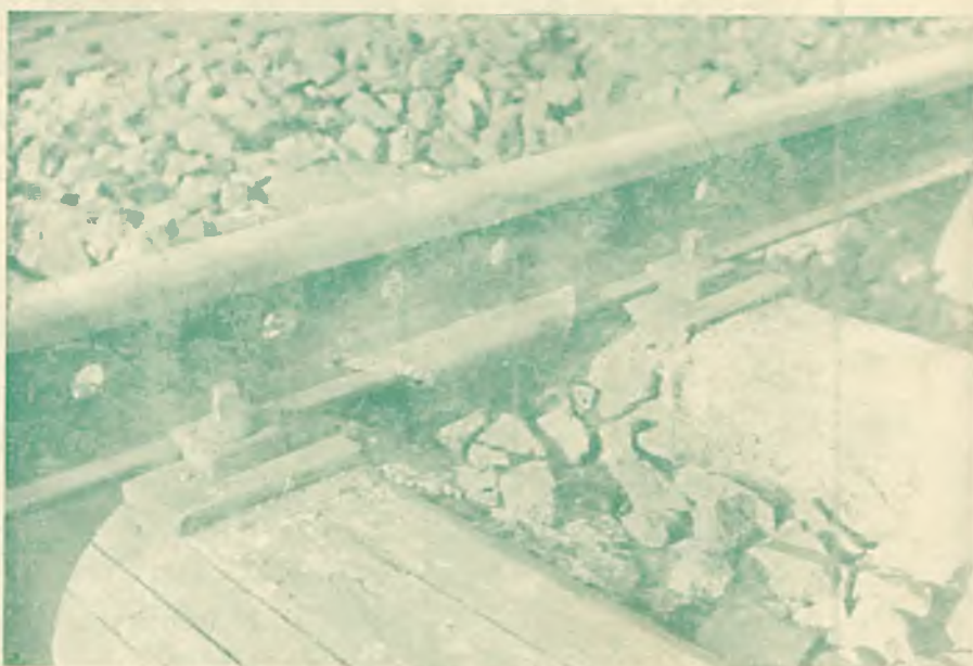
Złącze szynowe polskiej konstrukcji spawane palnikiem acetylenowym (do art. na str. 210).
