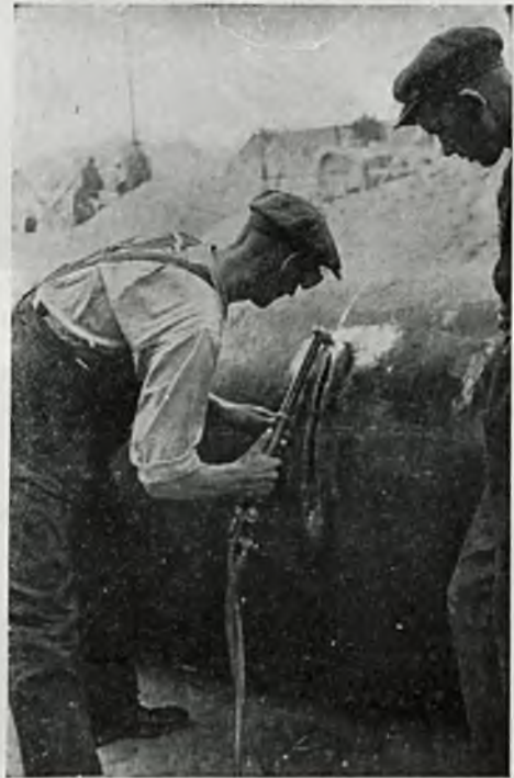
Rys. 4. Przecinanie rury żeliwnej w Warszawie.
