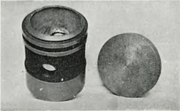
Rys. 14 i 15. Naprawa tłoka o urwanem denku. Wykonano nowe denko żeliwne i spojono je do korpusu tłoka, wypełniając jednocześnie wpustki na pierścieniu, aby umożliwić dokładne obtoczenie i wykonanie nowych wpustek. Czas pracy spawacza — 1 godz. Spożycie tlenu \frac{1}{2} m 3 , acetylenu rozpuszczonego— \frac{1}{2} kg. (Z praktyki Sp. Akc. Perun).
