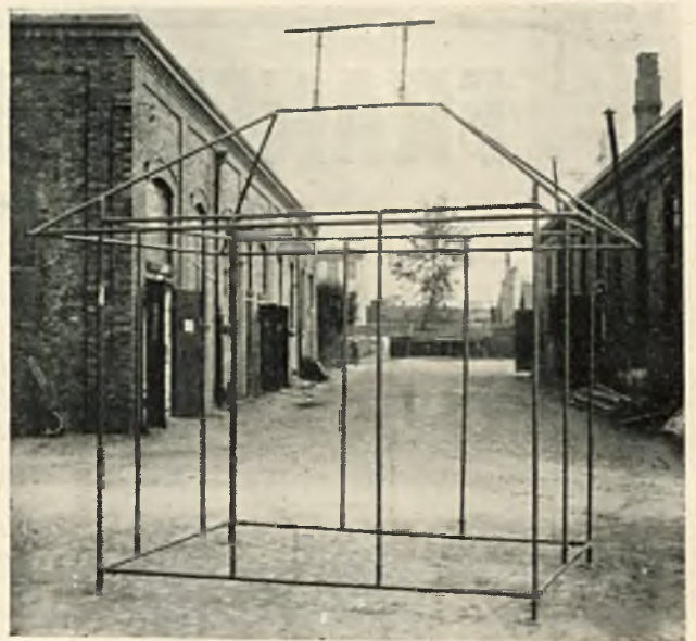
Szkielet namiotu, wykonany z rurek spawanych. (do art. na str. 146).
