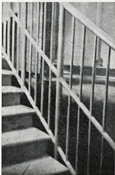
Rys. 3. Poręcz schodów z rur kotłowych.
