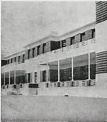
Rys. 1. Obramowanie werandy i balkonów wykonane z rur kotłowych.
