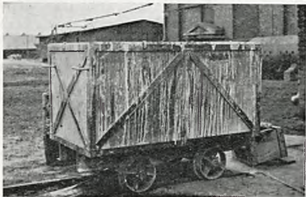
Rys. 1. Wózek spawany z blachy niklowej wykonany w Zakładach Elektro na G. Śląsku.
