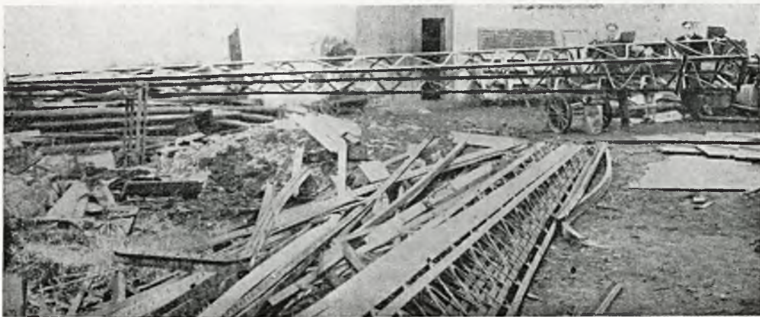
Rys. 1. Widok ogólny słupa.
