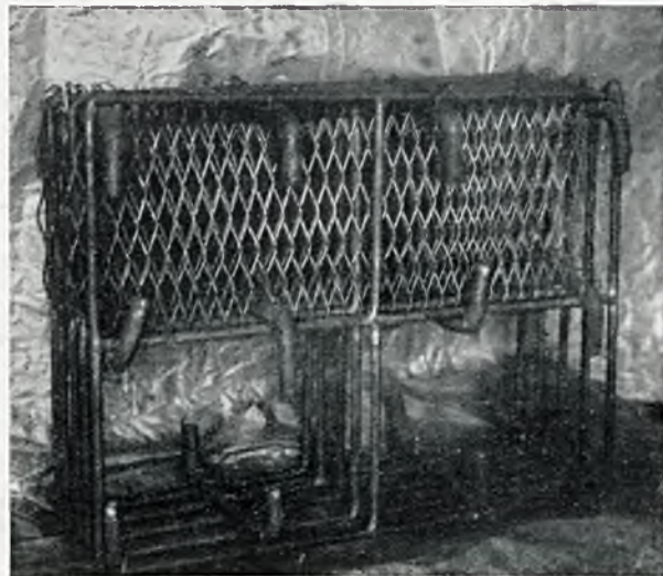
Uzbrojenie betonu zapomocą ramek i siatki, spawanych acetylenem.
