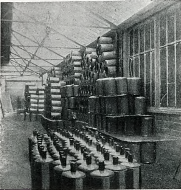
Rys. 7. Skład butli do butanu, spawanych acetylenem metodą „wgórnawskroś”
