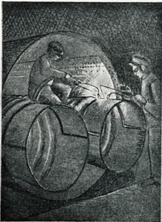
Rys. 1. Przed spawaniem miejsce pęknięcia zaznaczone białą kredą.
