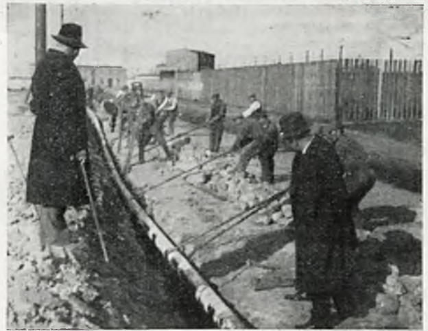
Rys. 5. Wpuszczanie spawanego odcinka do rowu przy pomocy kilkunastu lin.
