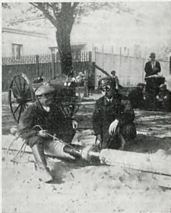
Rys. 2. Spawanie złącza.
