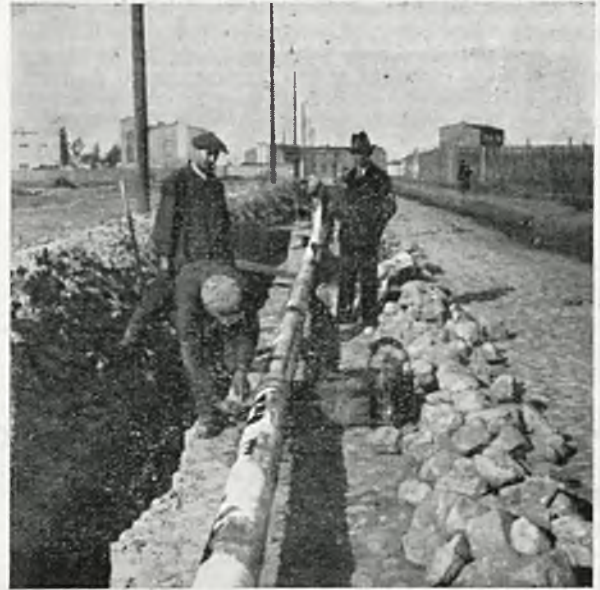
Rys. 4. Izolowanie szwu po spawaniu przy pomocy pasów jutowych.
