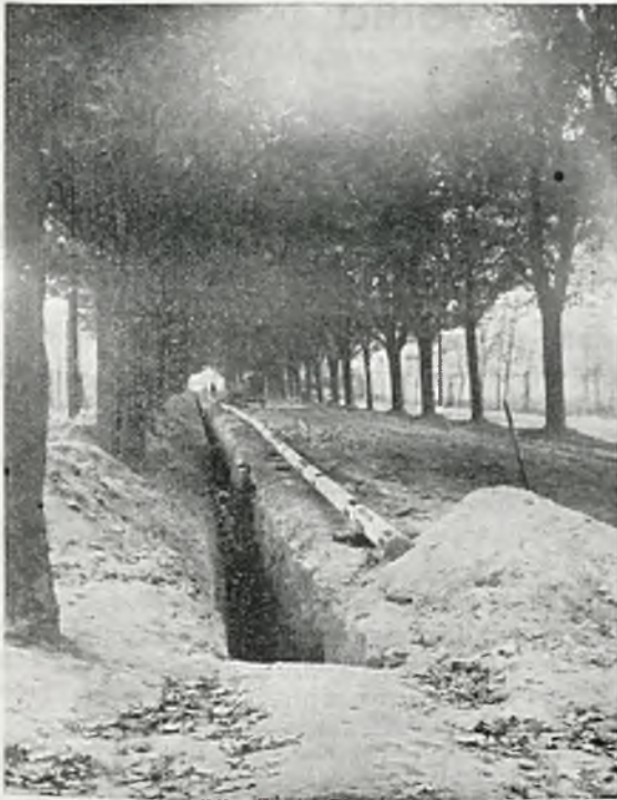
Rys. 3. Spojona część przewodu gazowego przygotowana do spuszczenia do rowu.
