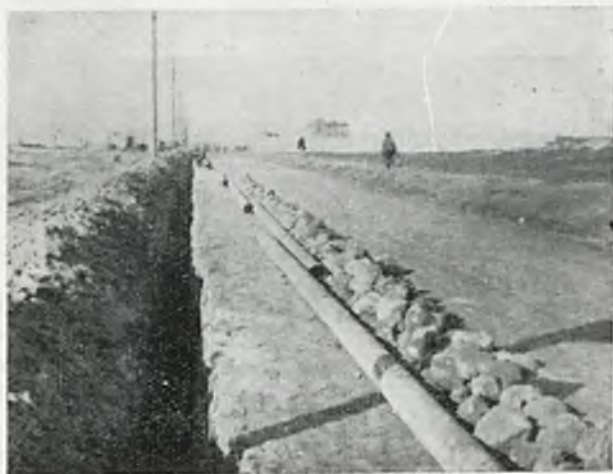
Rys. 1. Ułożenie odcinków rur wzdłuż wykopanego rowu.
