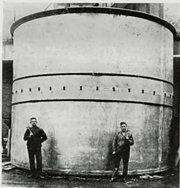
Rys. 12. Zbiornik aluminiowy pojemności 15 m 3 , przygotowany do spawania (uszczepiony nakładkami).
