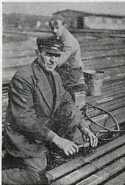
Rys. 6. Czyszczenie szyny zapomocą szczotki drucianej.
