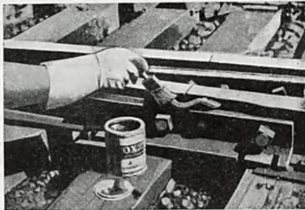
Rys. 15. Smarowanie łącznika w celu konserwacji.
