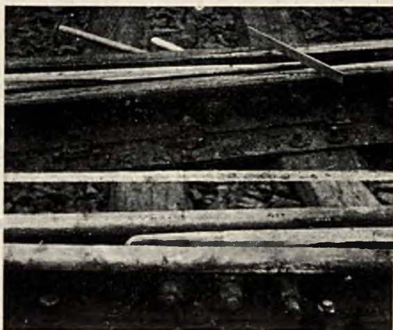
Rys. 6. Krzyżownica przed i po spawaniu.
