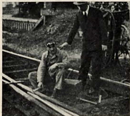
Rys. 5. Przekuwanie dzioba podczas napawania.
