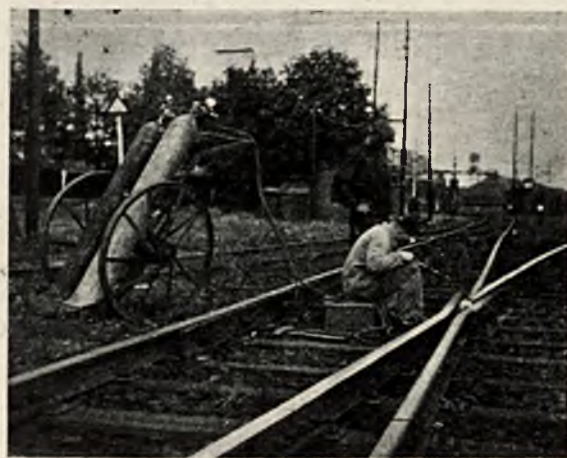
Rys. 4. Napawanie dzioba. Obok toru przewoźna instalacja do spawania.
