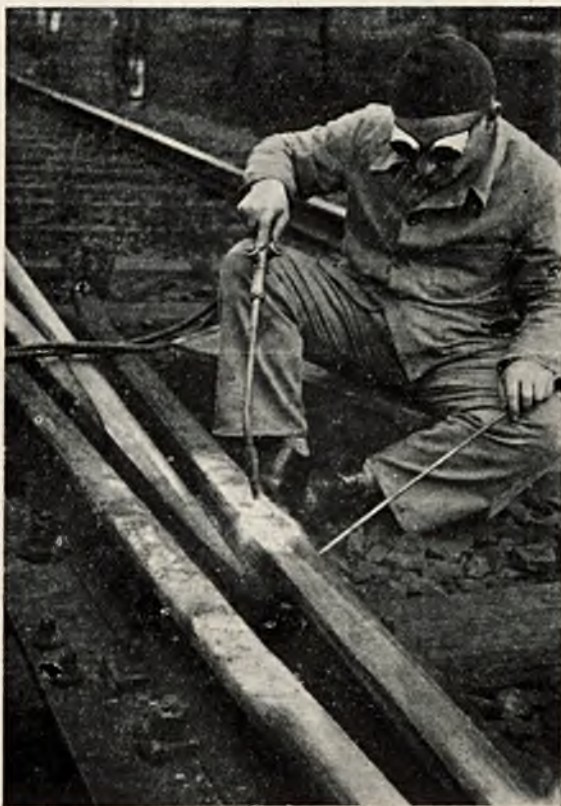
Rys. 3. Napawanie drugiej szyny skrzydłowej.
