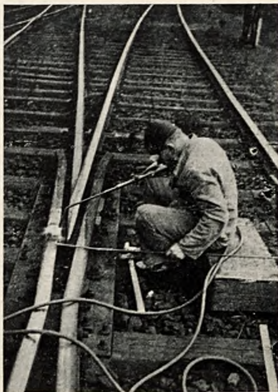
Rys. 2. Napawanie pierwszej szyny skrzydłowej.
