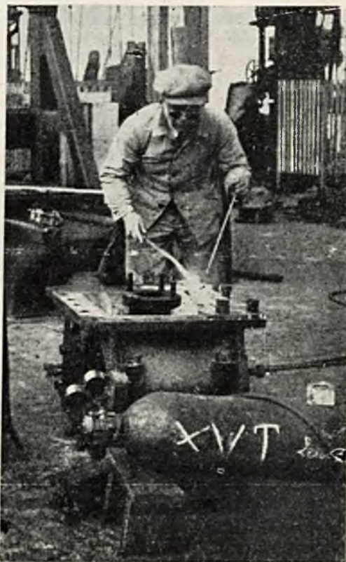
Rys. 10. Naprawa cylindra zapomocą lutowania palnikiem, przy użyciu drutu „Tobin”.
