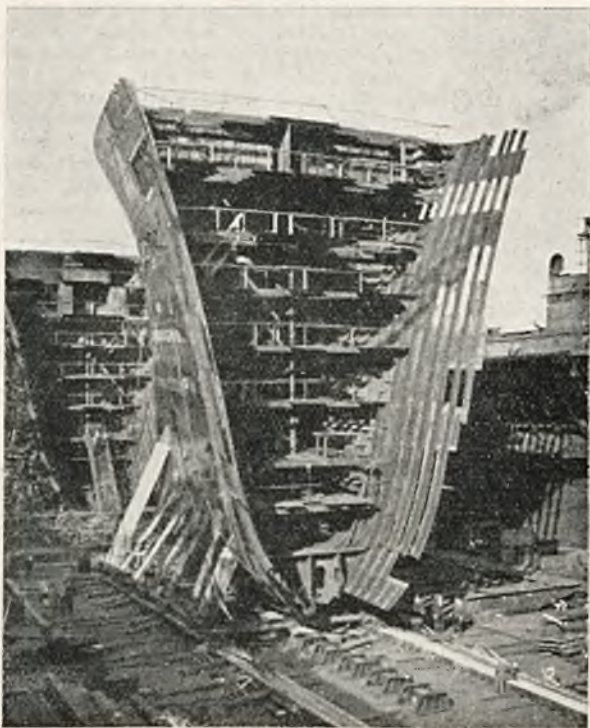
Rys. 1. Nowy przód okrętu zbudowany w doku przed rozpoczęciem rekonstrukcji statku.
