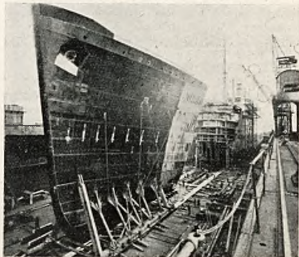
Rys. 2. Nowy przód i statek odpowiednio przerobiony—gotowe do połączenia.
