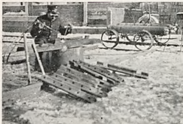
Rys. 3 a. Naprawianie łubków na torze.
