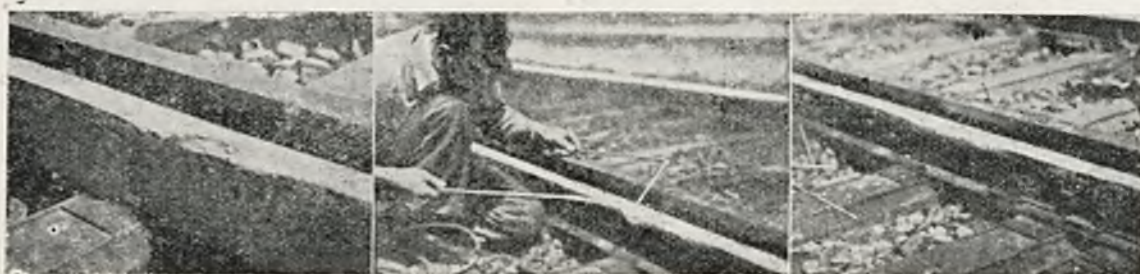
Rys. 4. Naprawa zapomocą spawania acetylenowego szyny zniszczonej wskutek defektu w materiale.
