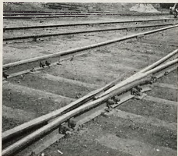
Rys. 5. Widok krzyżownicy silnie zużytej, przeznaczonej do naprawy zapomocą spawania acetylenowego.
