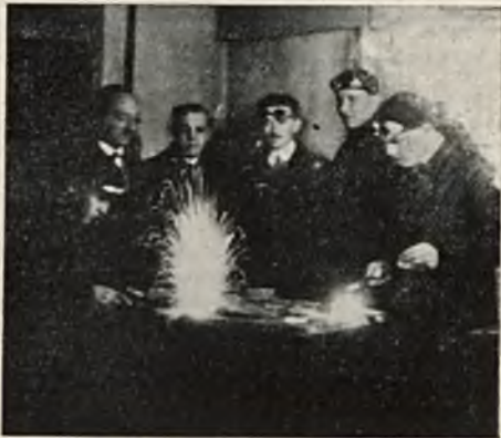
Ćwiczenia ze spawania acetylenowego (u góry) i elektryczno-łukowego (u dołu) na 26-ym kursie spawania w Warszawie.
