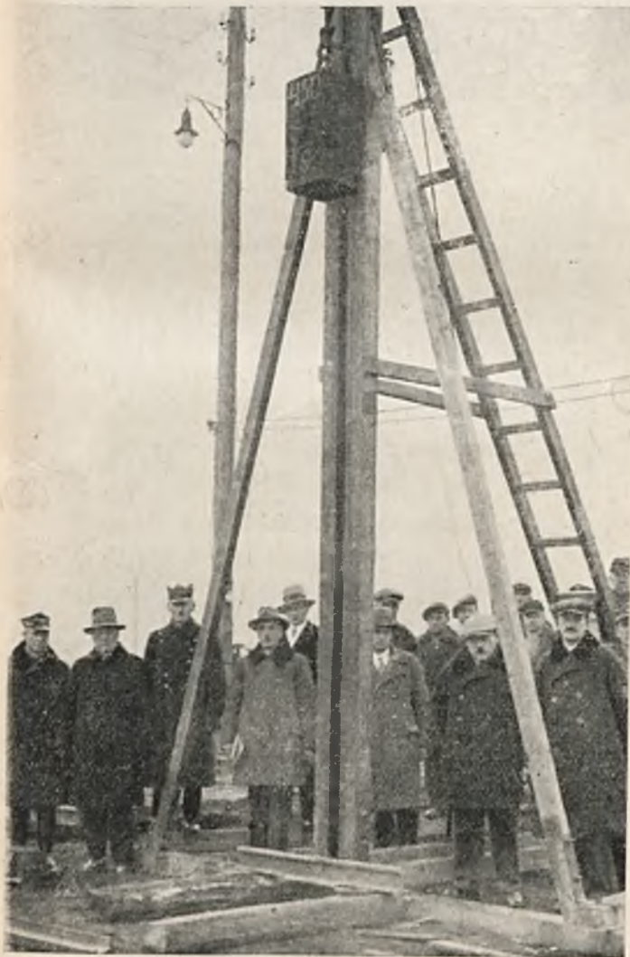
Złącze z podkładką spawane łukiem el., wytrzymało 4-krotne uderzenie bijakiem 450 kg. z wysok. 4 m bez pęknięcia, przy ugięciu 5 mm.
