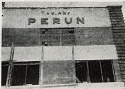
Rys. 1. Szyld wykonywany z blach zapomocą spawania acetylenowego.
