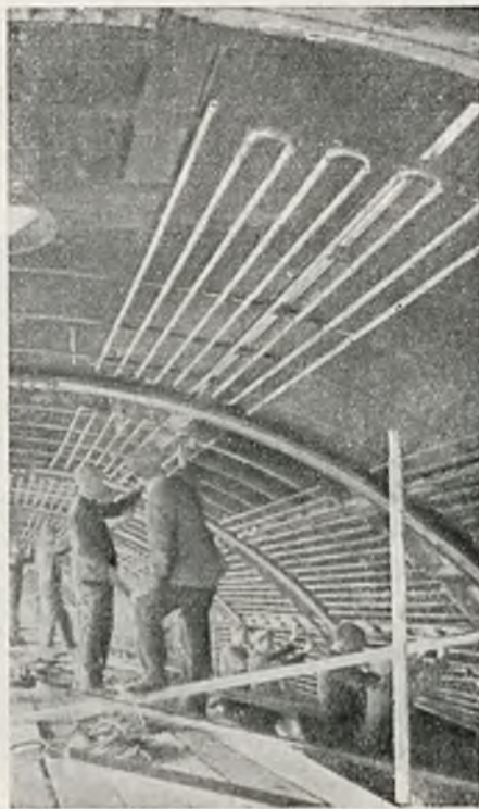
Rys. 153. Układanie promienników pod stropami łukowymi.
