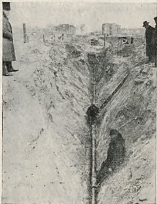
Rys. 133. Spawanie gazociągu w Warszawie.
