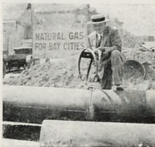
Rys. 128. Przyrząd do wycinania rur w celu zmiany kierunku rurociągu.
