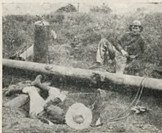
Rys. 134. Spawanie „nad głową“ poszczególnych odcinków rurociągu.
