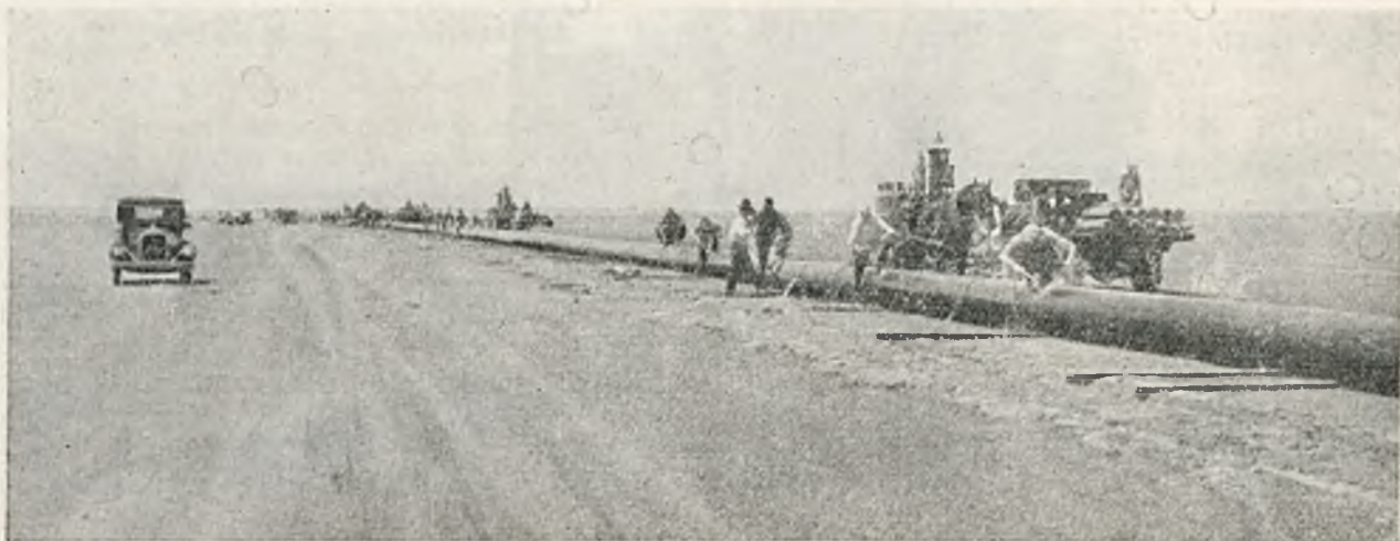
Rys. 132. Przy rurociągach dużej średnicy osobne drużyny spawaczy zajmują się tylko szepianiem rur, samo zaś spawanie wykonywane jest przez innych spawaczy przy obracaniu całego odcinka szepianego.
