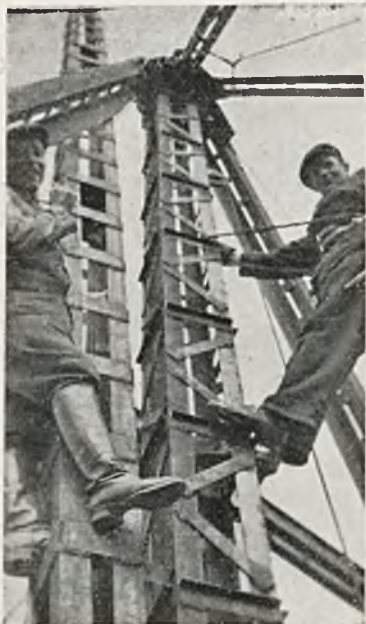
Rys. 6. Żóraw-derrick spawany.
