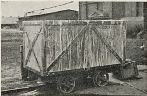
Rys. 4. Wózek spawany z blachy niklowej.
