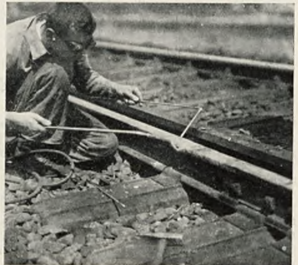
Rys. 11. Napawanie szyny z rys. 10 palnikiem acetylenowo-tlenowym, bez wyjmowania szyny z toru.
