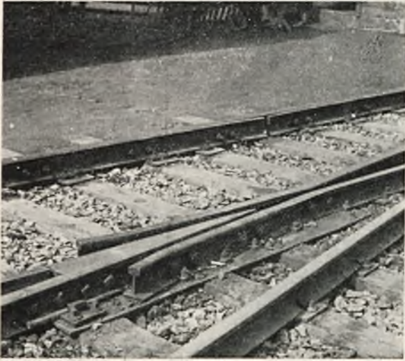
Rys. 8. Krzyżownica naprawiona w torze w Dyr. Katowickiej.
