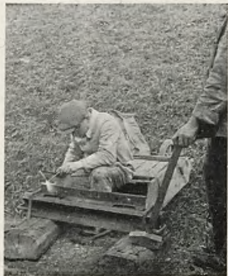
Rys. 20. Napawanie łubka.
