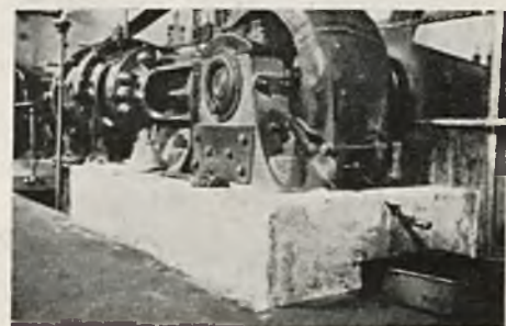
Rys. 3. Pompa w ruchu po naprawie.
