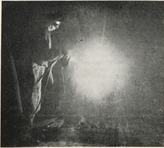
Rys. 4. Cięcie ściany pancernej skarbcza.
