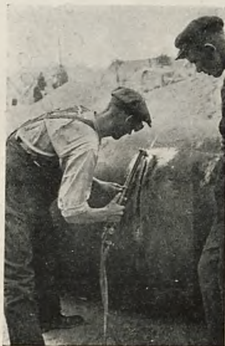
Rys. 2. Przecinanie rury żeliwnej.
