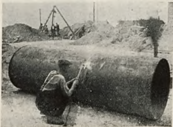
Rys. 1. Przecinanie rury żeliwnej.
