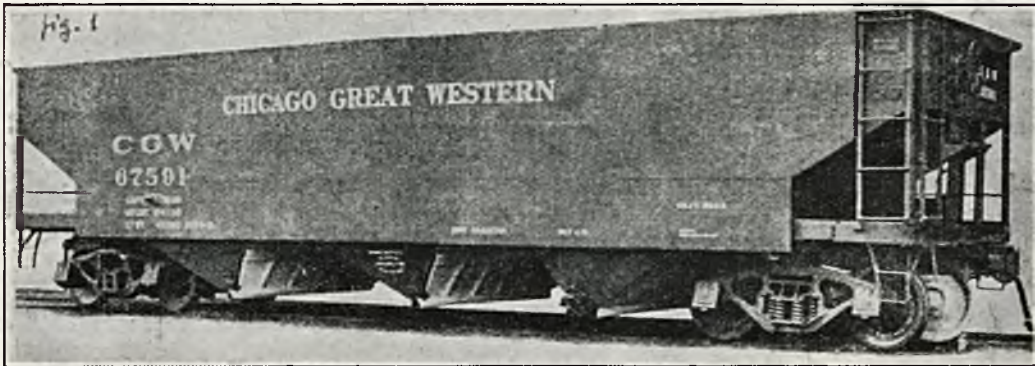
Rys. 1. Widok ogólny węglarki 75-tonnowej całkowicie spawanej.
