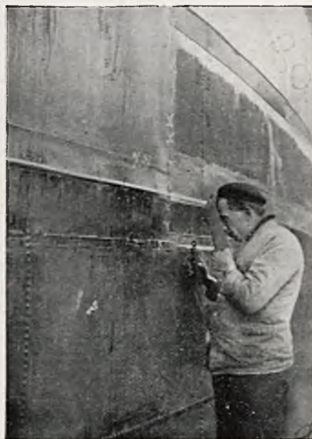
Rys. 4. Nakładanie pasów od strony wschodniej.
