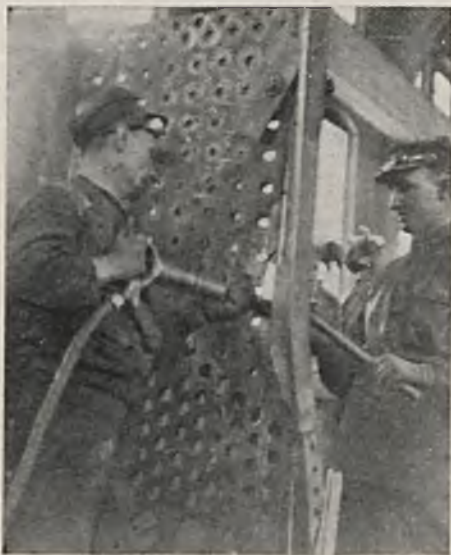
Rys. 5. Przekuwanie spoiny.
