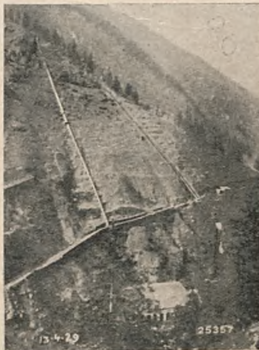
Rys. 9. Rurociągi spawane doprowadzające wodę do stacji hydroelektrycznych w Szwajcarii.
